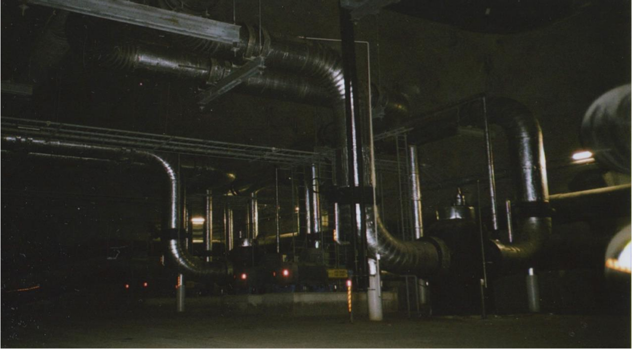
Näkymä maanalaisista tunneleista Helsingissä vuonna 2021
