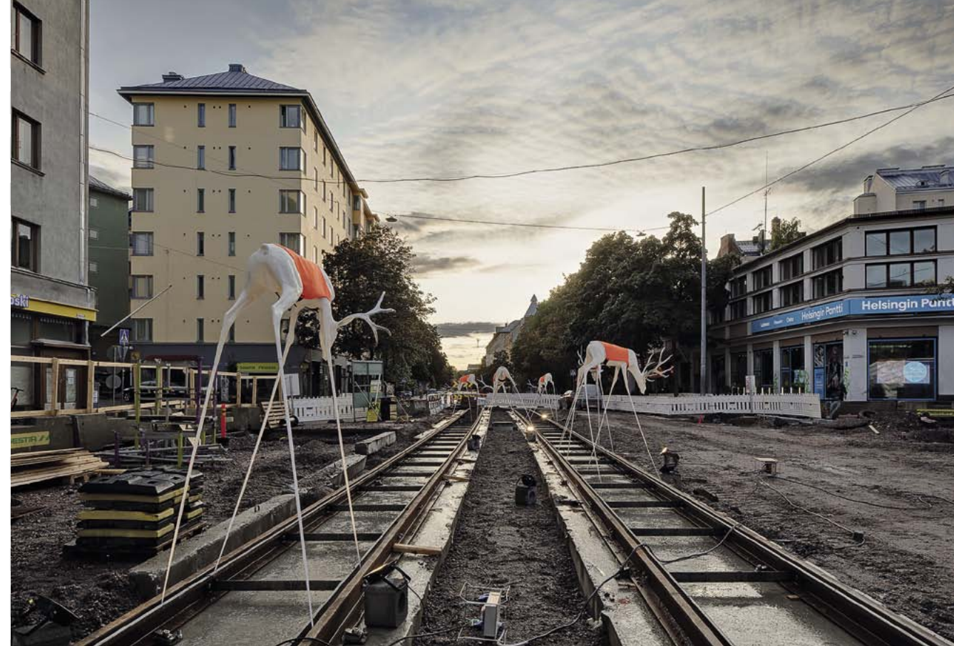
5. Timo Heimon Sokea lauma Kurvissa Hämeentien rakennustyömaan keskellä.
