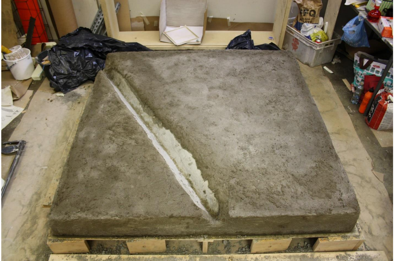
Kivijalan ensimmäinen betonikerros.
