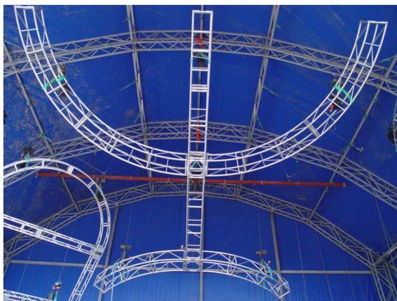
Kynttelikkö ja USR ikkuna valmiina
