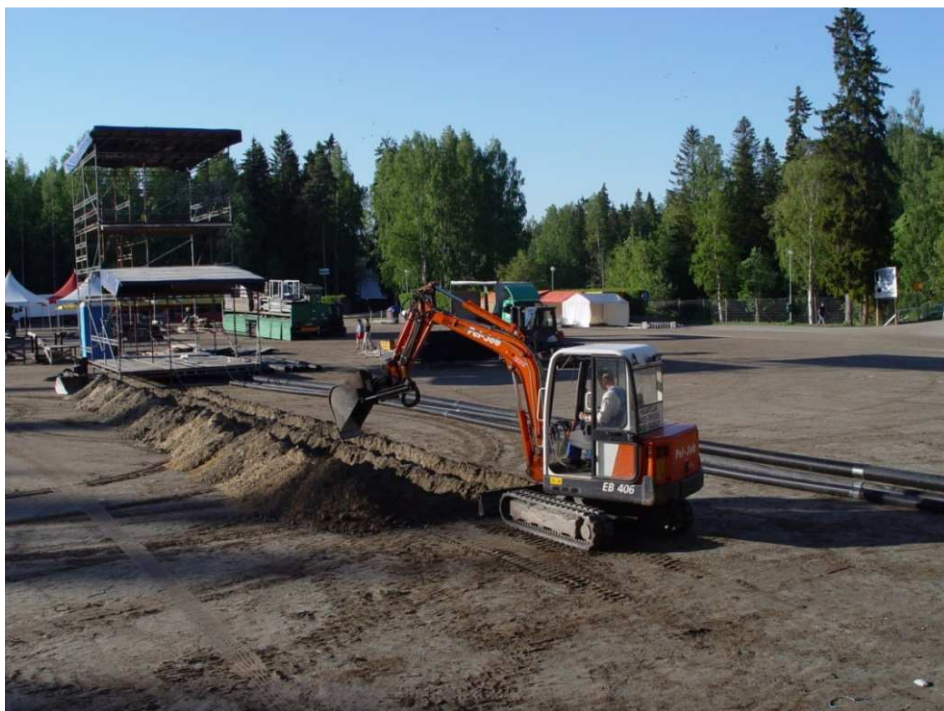
Kaapeliputkille avataan kuoppaa lavan ja FOH:in välille.
