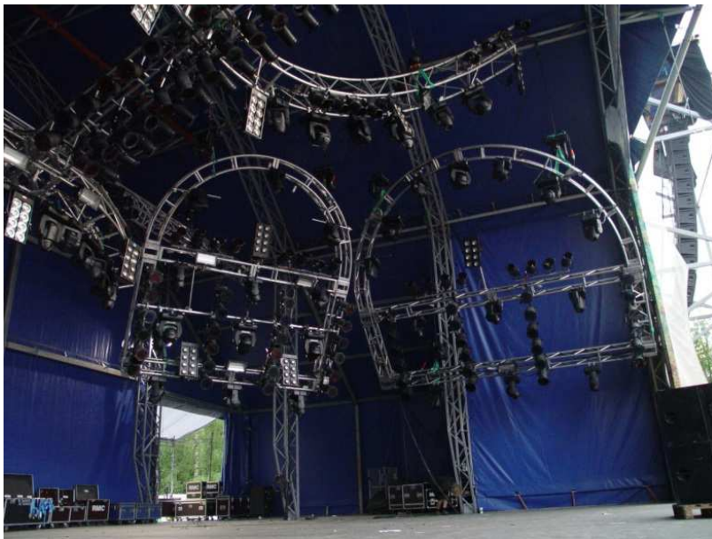
SL ikkunat ja kynttelikkö kalustettuna, kaapeloituna ja testattuna
