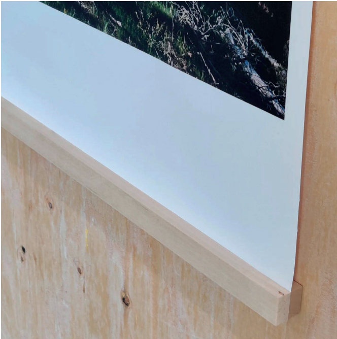
Lähikuva vedosten puupäädystä tai ”kehyspuista”. 2 kpl koivurimoja (80 x 2 x 1 cm), joiden väliin vedos kiinnittyy. © Lauri Lähteenmäki
