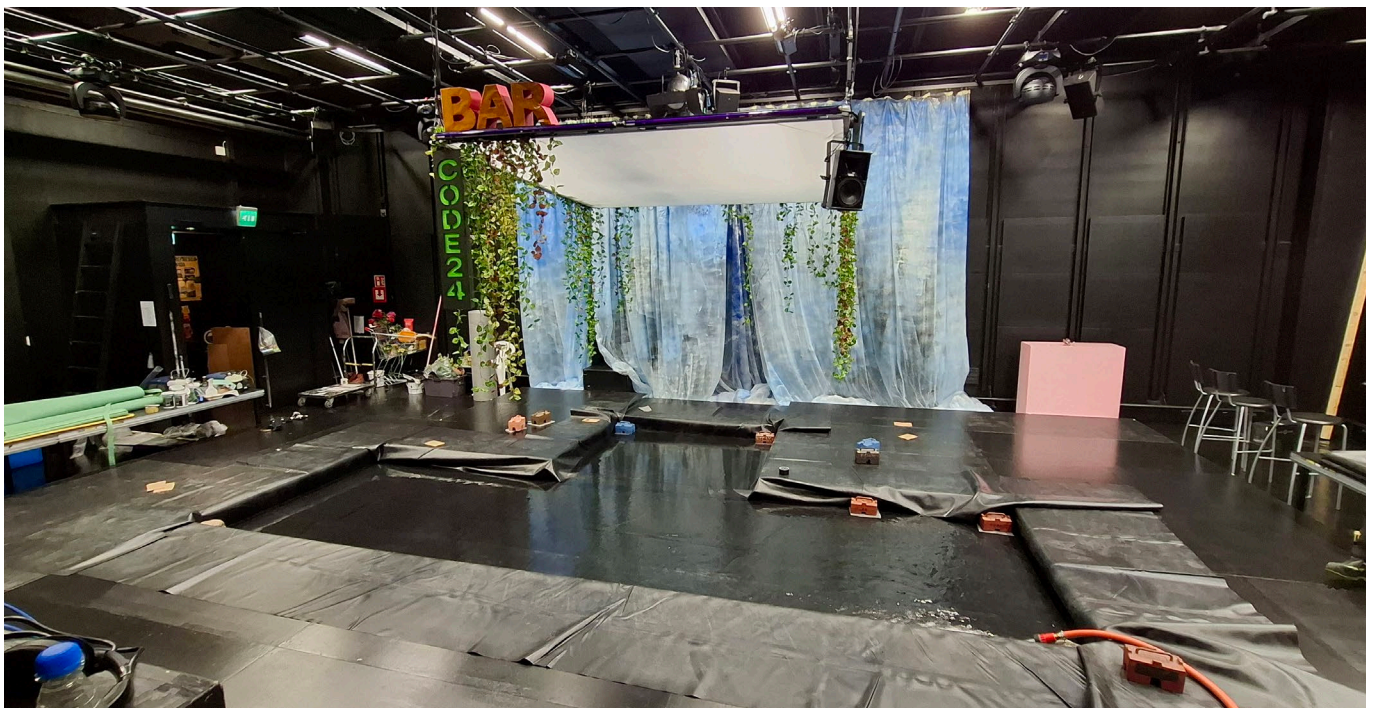
Kuva 21: Kuva altaan täytöstä allaskumin asettelun jälkeen.
