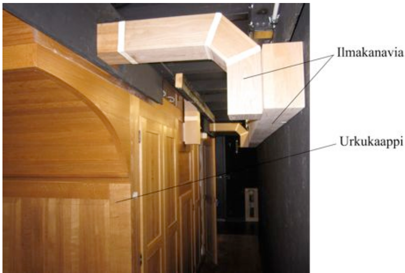
KUVA 7. Ilmakanavat urkujen takana.
