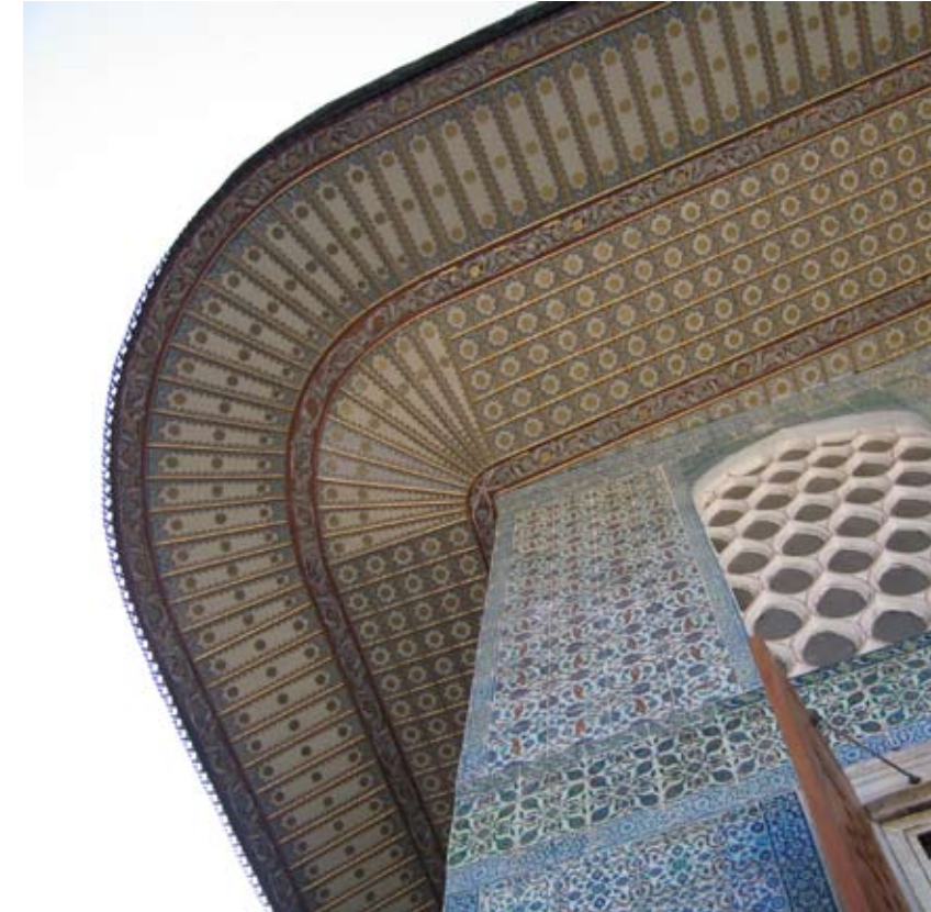
Taksprånget på en byggnad i Topkapi palatset i Istanbul (Twin Kiosk).1700-talet.
