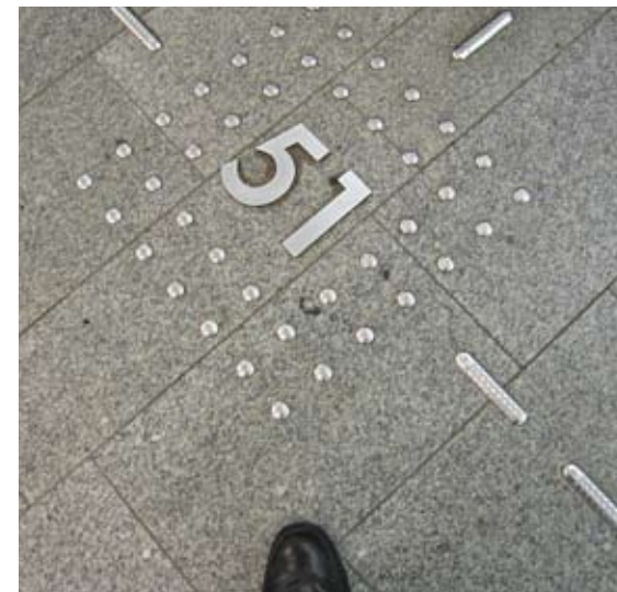
Ornamentering med funktion. Vägvisning för synskadade i Kampens busstation, 2005, Helsingfors.
