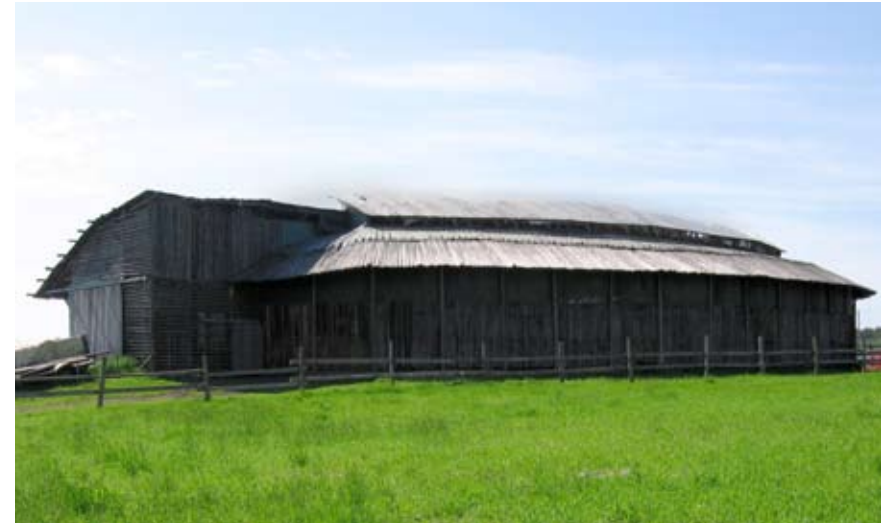
Rosegarden (Jan-Erik Andersson och Erkki Pitkäranta). Kummin - den ekologiska ladugården . 1997. Fasaden är gjord av det rundade virke som blir över när man gör plankor av trädstammar.
