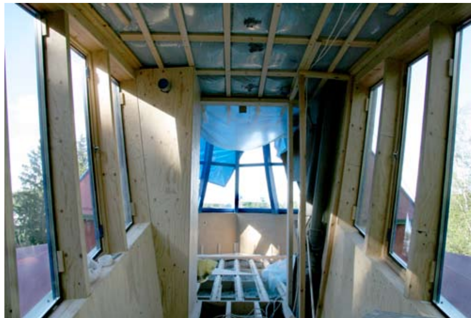
Det byggda huset har inga fönster längst bak för att skydda mot solljuset. Även utseendet på de vertikala bärande balkarna har ändrats. 10.8.2008.
