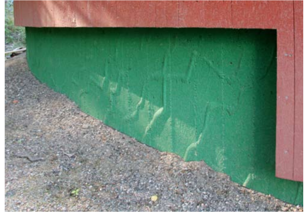
Ornamentiken för sockeln på lagerbygganden färdiggjord. 2008.
