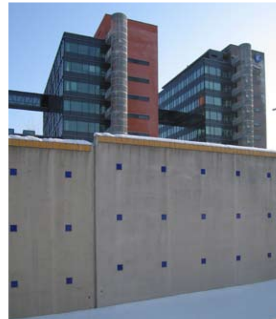
Ornamentering av skyddsvägg invid Kuppis järnvägsstation, Åbo. Bilden tagen 2007.
