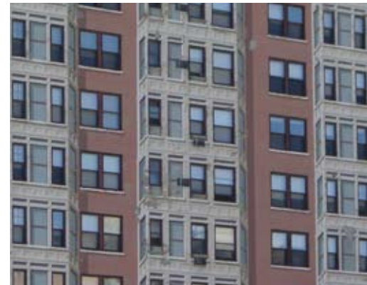
Ornamentet som illusion. De ljusare partierna på fasaden är påmålade och ger en illusion av en byggnad med utskjutande partier. Bostadshus i Chicago. Bilden tagen 2005.
