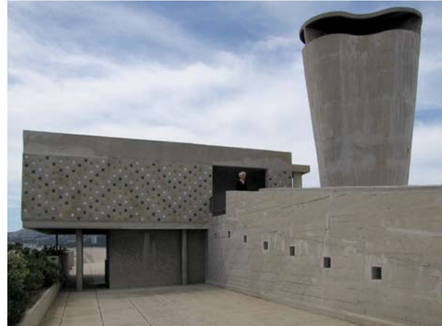
Le Corbusier. Unité d'habitation , Marseille (1947-52).
