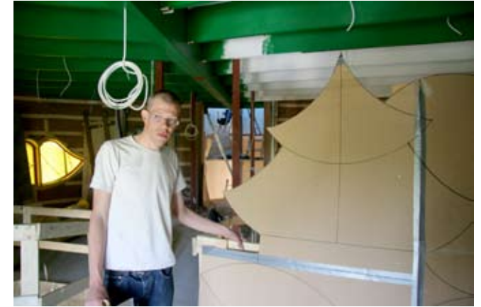
Hantverksstuderande Viktor Nylund gör den kombinerade bokhyllan och väggen för sovloftet. Här med skissen i skalan 1:1. 2008.
